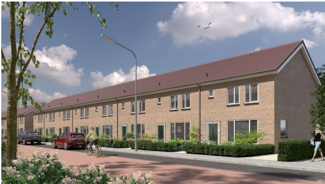
DE VOORBEREIDING VOOR DE VERDUURZAMING VAN 45 EENGEZINSWONINGEN IN DE SCHILDERS-/DICHTERSBUURT IS IN VOLLE GANG. VOLGENS PLANNING BEGINNEN DE WERKZAAMHEDEN IN MAART 2024. NIET ALLEEN WORDEN DE WONINGEN GOED GEÏSOLEERD, OOK WORDEN DE RAMEN EN MECHANISCHE VENTILATIE VERVANGEN.
