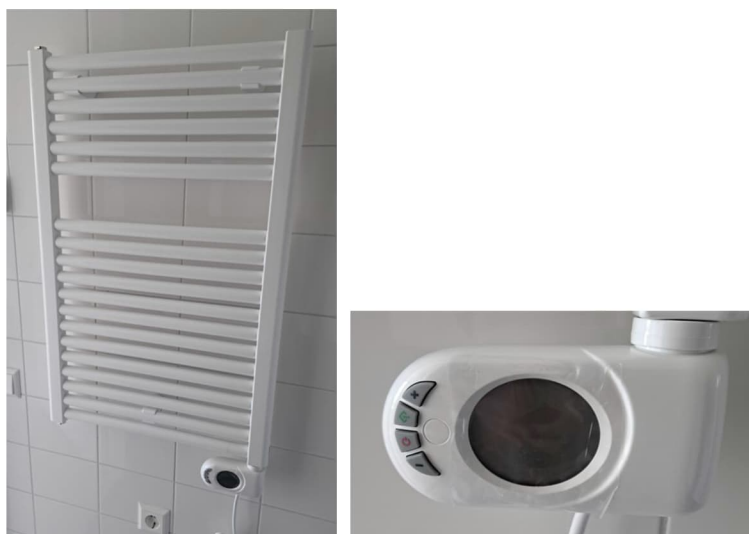
Afbeelding: E-radiator- thermostaatknop
