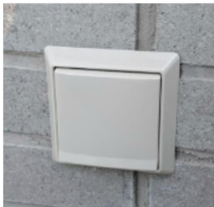
Afbeelding: buitenstopcontact
