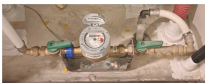
Afbeelding: watermeter
