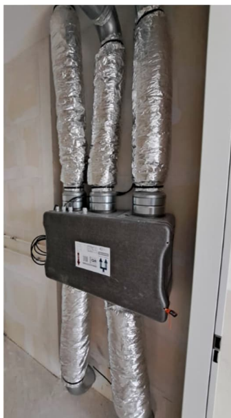
Afbeelding: Cera-ventilatie unit
